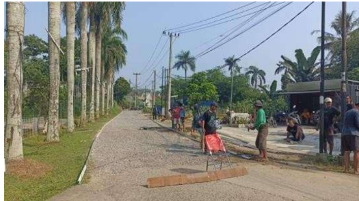
Gambar 3. Perbaikan Jalan Akses ke Eduwisata Bumi Insani Tonjong
